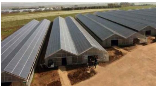
Figure 47 : Ferme de Scu Scioffu, ensemble de serres photovoltaïques d'une capacité totale de 20MW en Sardaigne (développeurs Mbccl et Twelve Energy) (Tagliaferri s. d.)
