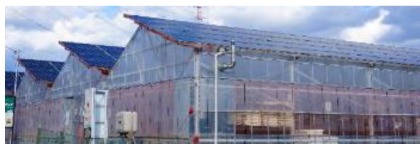
Figure 43 : Exemple d'une serre photovoltaïque au Japon, sur cultures hydroponiques de moutarde, pamplemousse, roquette, laitue et basilic
